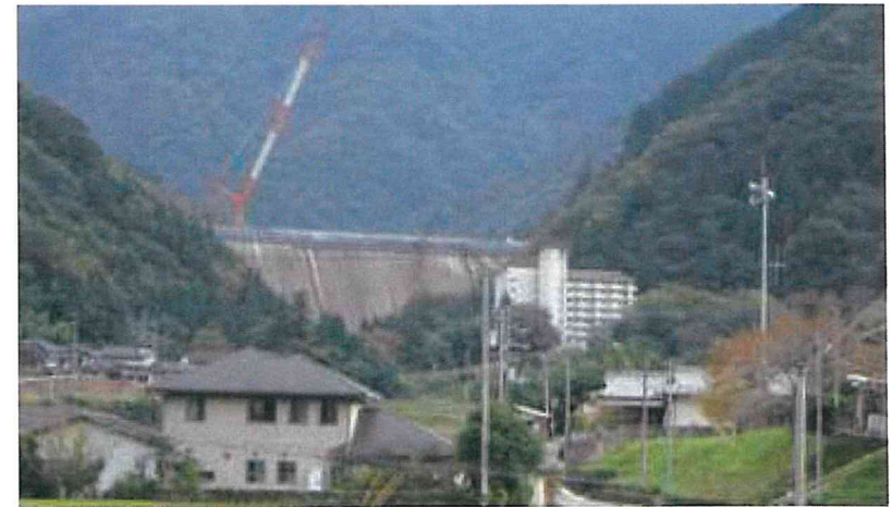
ダム打設状況（下流から）R1.10
