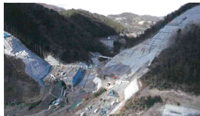
ダム打設状況（上流から）H30.1
