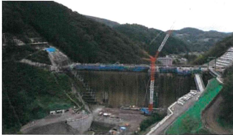
ダム打設状況（上流から）R1.10
