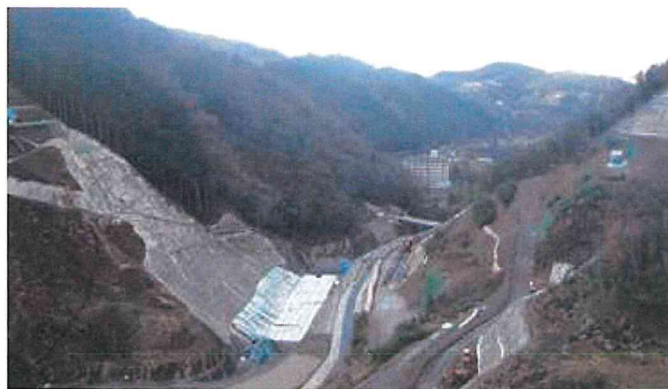
ダム打設状況（上流から）H28.12
