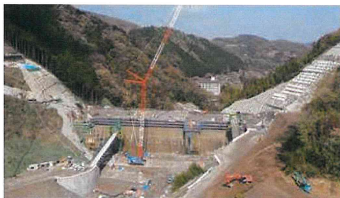
ダム打設状況（上流から）H31.4
