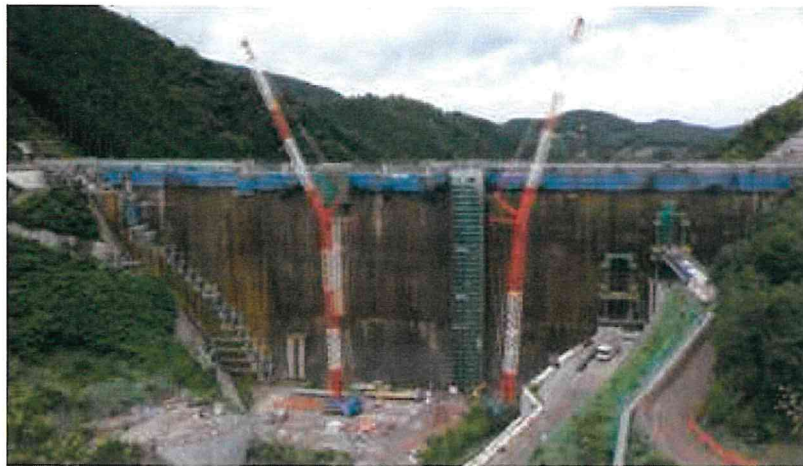
ダム打設状況（上流から）R2.7
