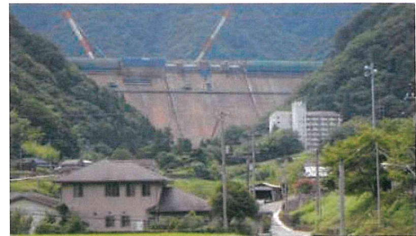
ダム打設状況（下流から）R2.7
